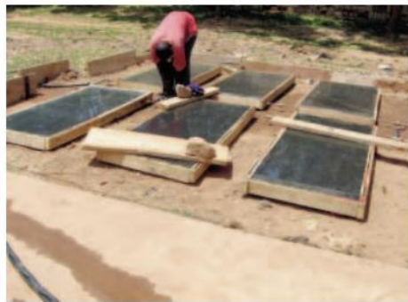
Construction d'un four.
